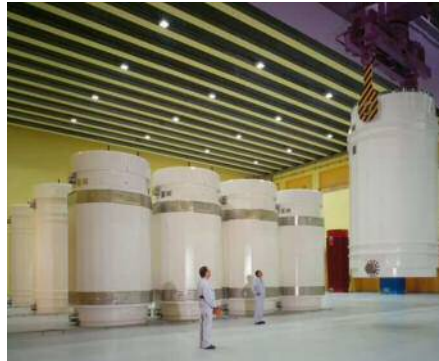
Zwischenlager für hochradioaktive Abfälle in Würenlingen.
